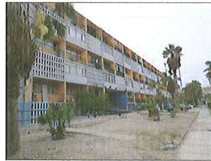
Fachada principal del edificio.
