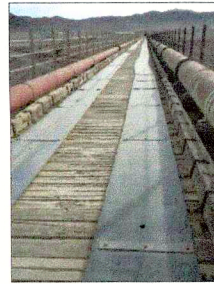
Detalle de cubierta situación actual
