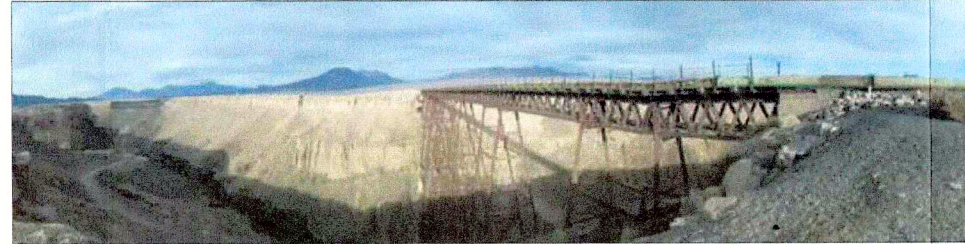
Vista norte del Viaducto
