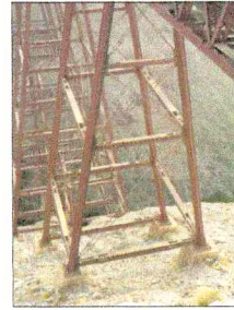
Detalle de torre caja piramidal con fundación de sillería en piedra
