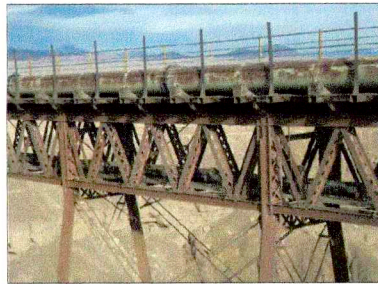
Detalle de viga reticulada
