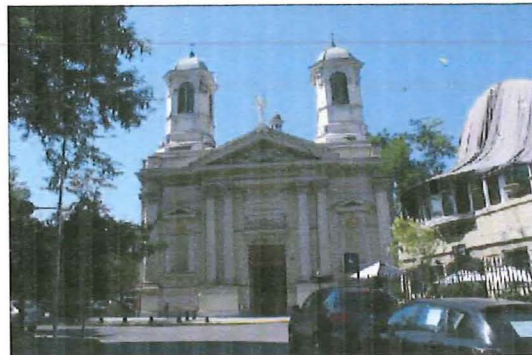
Fachada principal Templo Parroquial de los Santos Ángeles Custodios
