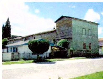
Vista fachada suroriente del Teatro Galia (calle Unión)
