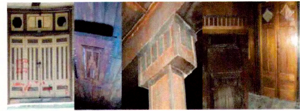
Detalle de terminaciones exteriores e interiores de madera (puertas, cielos y capitel)
