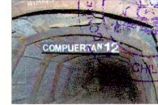
Galería subterránea, Compuerta N° 12
