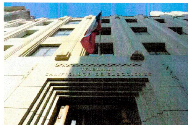
Acceso principal desde la fachada norte por calle Compañía de Jesús
