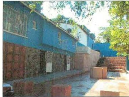
Fachada principal desde calle Márquez de la Plata
