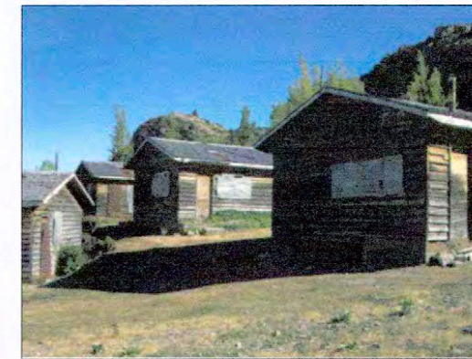
Vivienda Obreros (tipología simple a dos aguas)
