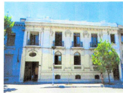
Fachada principal de Fundación de ayuda Social de las Iglesias Cristianas
