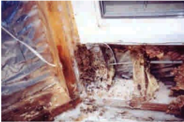
Figura 2 – 19: El no tomar resguardo contra las termitas y asesorarse por expertos puede tener consecuencias de alto costo en las viviendas.
