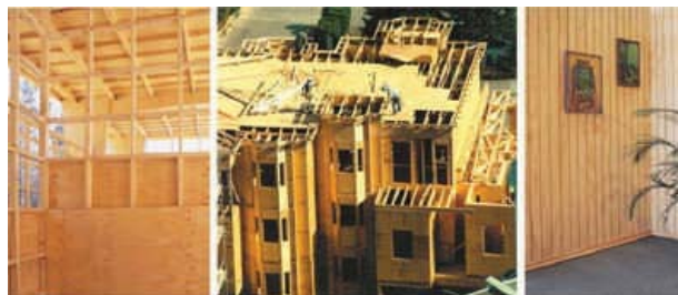
Figura 1 - 84: Ejemplos de aplicación de los tableros contrachapados en requerimientos estructurales y decorativos.
