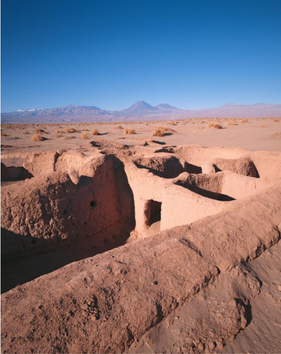
Vista parcial de los muros semienterrados de la Aldea de Tulor. Fotografía Fernando Maldonado. ATACAMA. Museo de Arte Precolombino. 2012
